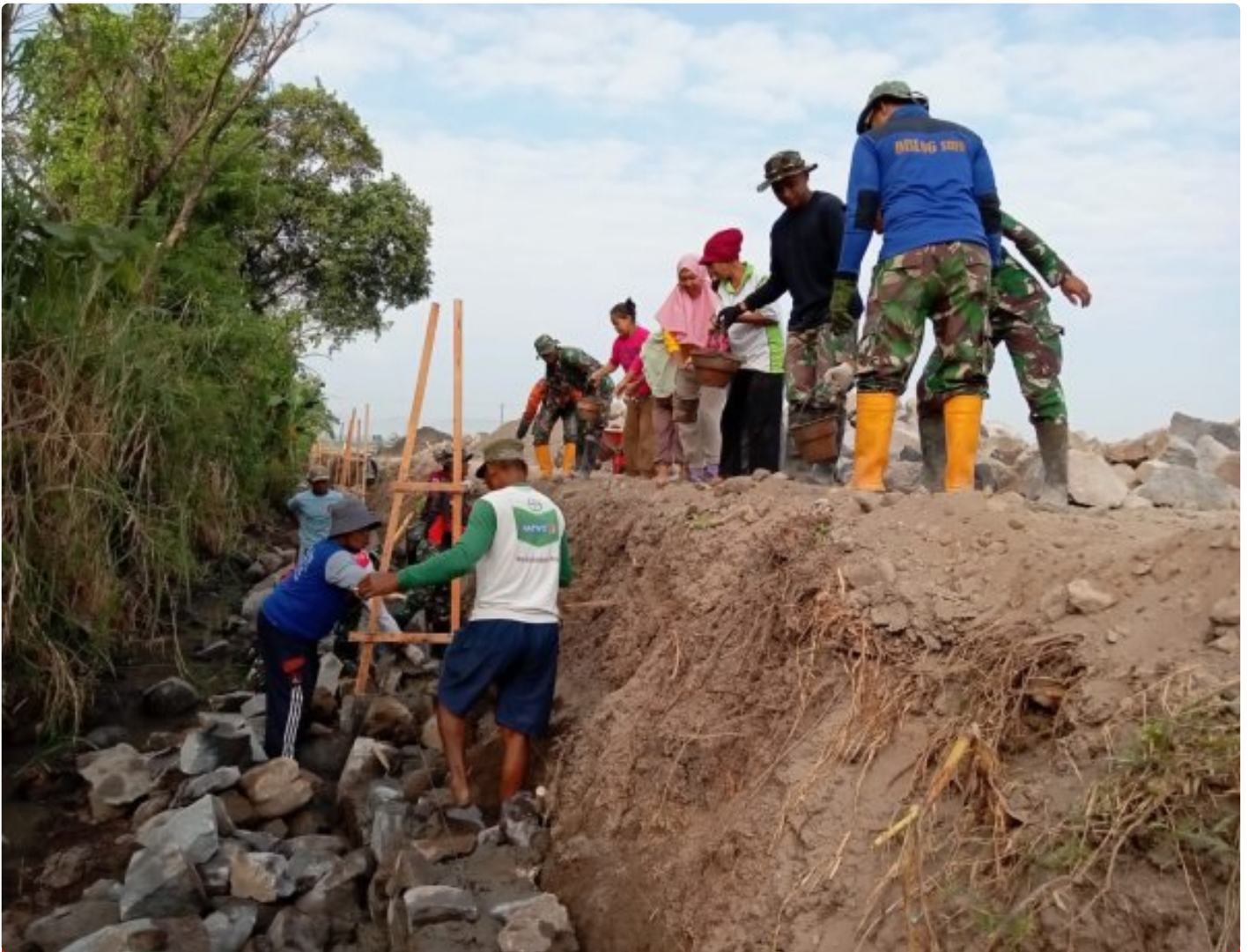
TNI bersama Warga Gugur Gunung kebut Pembuatan Talud TMMD
